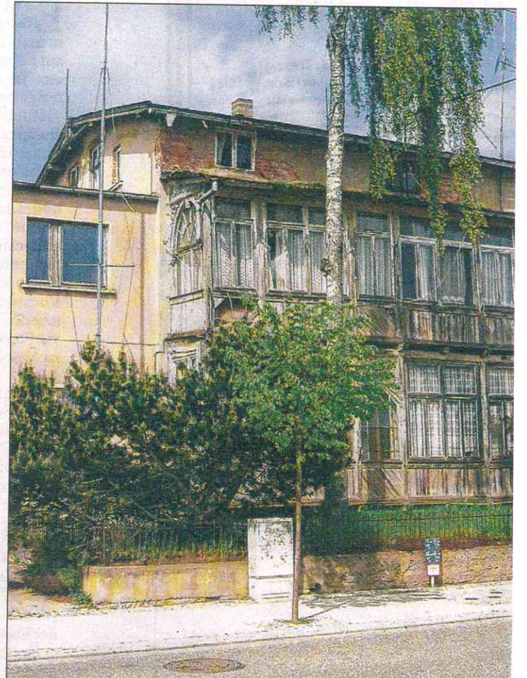
So sah das alte Haus Dörf vor dem Abriss aus. Das Gebäude war nicht mehr zu retten, aber beim Neubau auf ähnliche Holzkonstruktion
