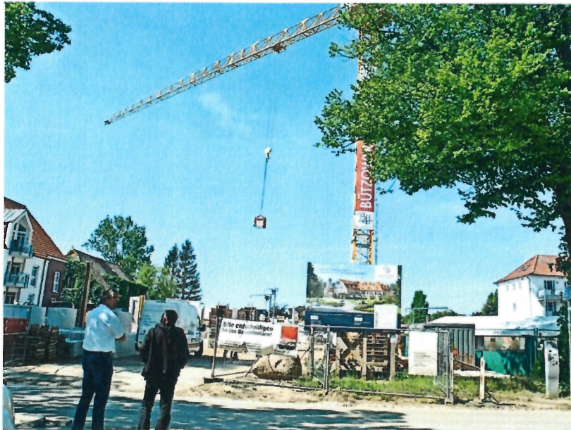
Kran-Tänze – Baustelle „Baltischer Hof“ Boltenhagen
