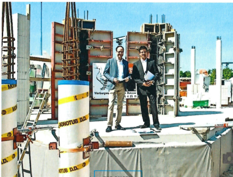
Zeitkapsel versenkt im Fundament „Baltischer Hof“ Boltenhagen
